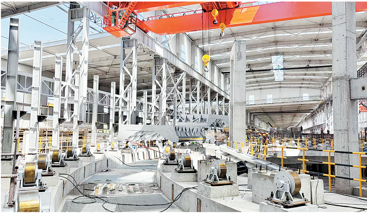
项目建设现场
