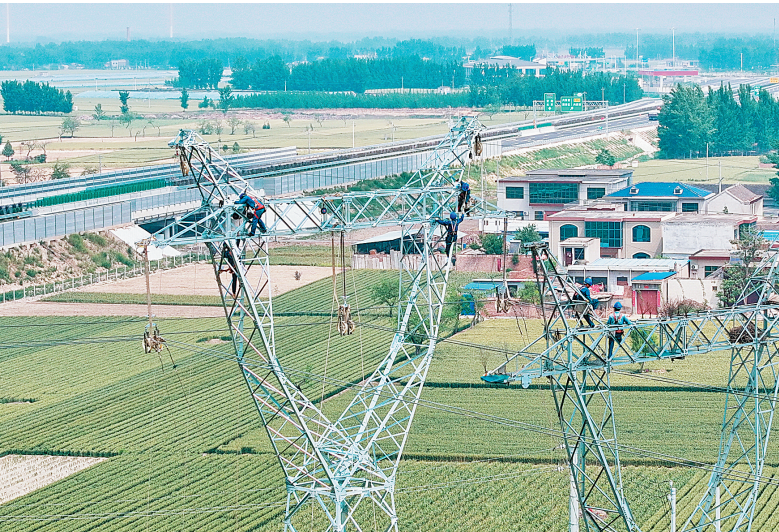
5月12日，在内黄县高堤乡，国网安阳供电公司组织施工人员对220千伏滙帝输电线路跨越京武高速公路段实施升级改造，消除夏季极端天气下可能出现的安全隐患。(本报记者 邓娟 摄)
