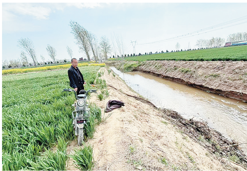
二级河渠水流全面覆盖苦水区核心灌溉片区后农户取水灌溉的情景(王辉 摄)
