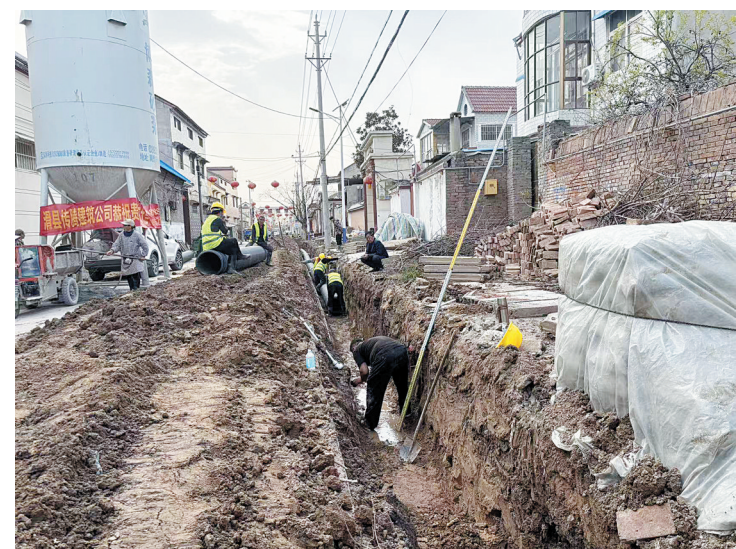
施工现场(姜浩 摄)
