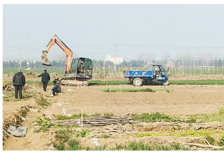
施工现场(臧森垚 摄)
