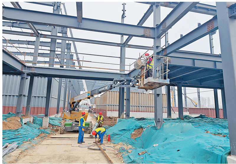
汤阴县城南中华路污水处理厂项目施工现场(本报记者 牛思明 摄)
