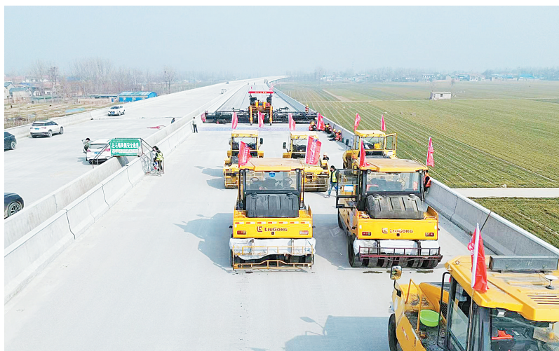
安罗高速安阳段项目施工现场(资料图)
