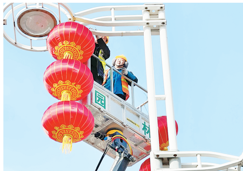
大红灯笼高高挂,张灯结彩迎新春。为使春节氛围更加浓厚,市智慧城市运行中心组织人员在主干道安装象征幸福圆满的大红灯笼,营造欢乐祥和的节日氛围,为整座城市增添了一道亮丽的风景线。图为1月10日,工作人员正在安装大红灯笼。(本报记者 王慧敏 摄)
