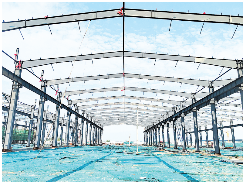
年产1000万芯公里数字通讯光纤光缆及配套辅件项目建设现场
