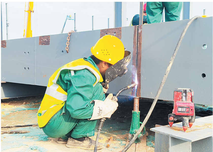
年产15万吨轨道交通配件生产基地项目正在施工
