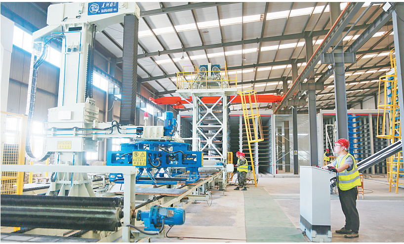
生态绿色建筑材料(拓安二期)项目现场
