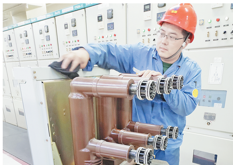
杨鹏进行设备安装
