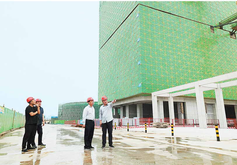
派驻组工作人员到市儿童医院新院区工程建设现场调研(宋玮 摄)
