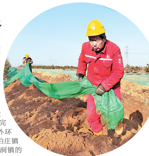
西南外环高压天然气管线项目 施工工人在铺设防风抑尘网 (本报记者 邓娴 摄)
