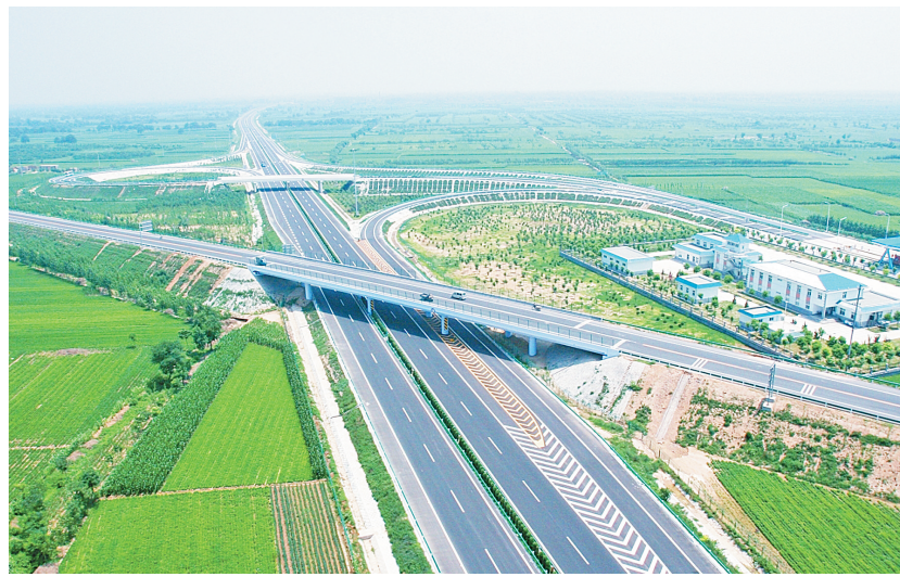
安阳至林州高速公路互通式立交桥(资料图)
