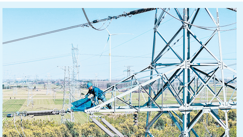
随着生态环境日益好转,我市的大型鸟类逐年增多,一些大型鸟类喜欢在电力铁塔上搭窝筑巢,给电网安全带来严重威胁。国网安阳供电公司组织人员在电力铁塔上安装彩色驱鸟挡板,防范鸟类活动引发输电线路跳闸事故和鸟类被电击伤害情况发生。图为11月17日,该公司工作人员在安阳220千伏涇帝线139号塔安装驱鸟挡板。(张阳 李玺 摄)
