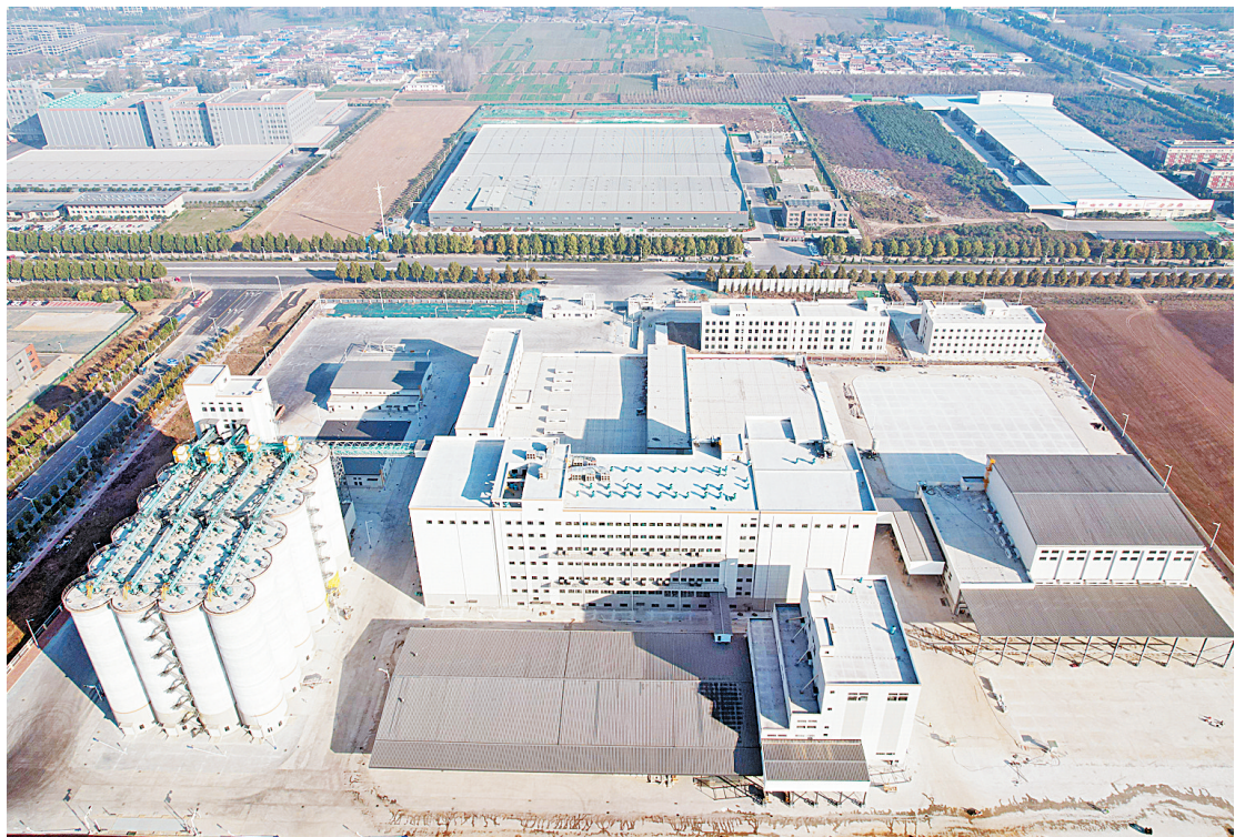
中粮粮谷项目建设现场鸟瞰
