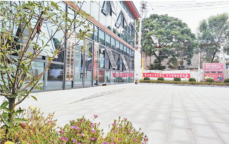
拆除围墙后的遵贵屯村村委会
