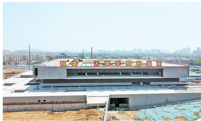
殷墟遗址博物馆主体工程施工现场(资料图)
