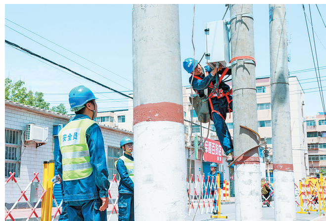
作业人员正在安装智能馈线终端(郭栋摄)
