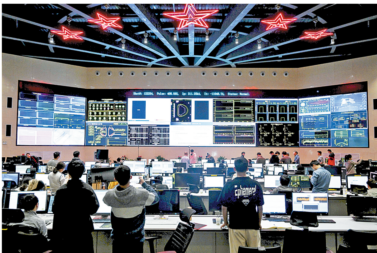
这是实验成功后的全超导托卡马克核聚变实验装置(EAST)控制大厅(2023年4月12日摄)(新华社记者黄博涵摄)
