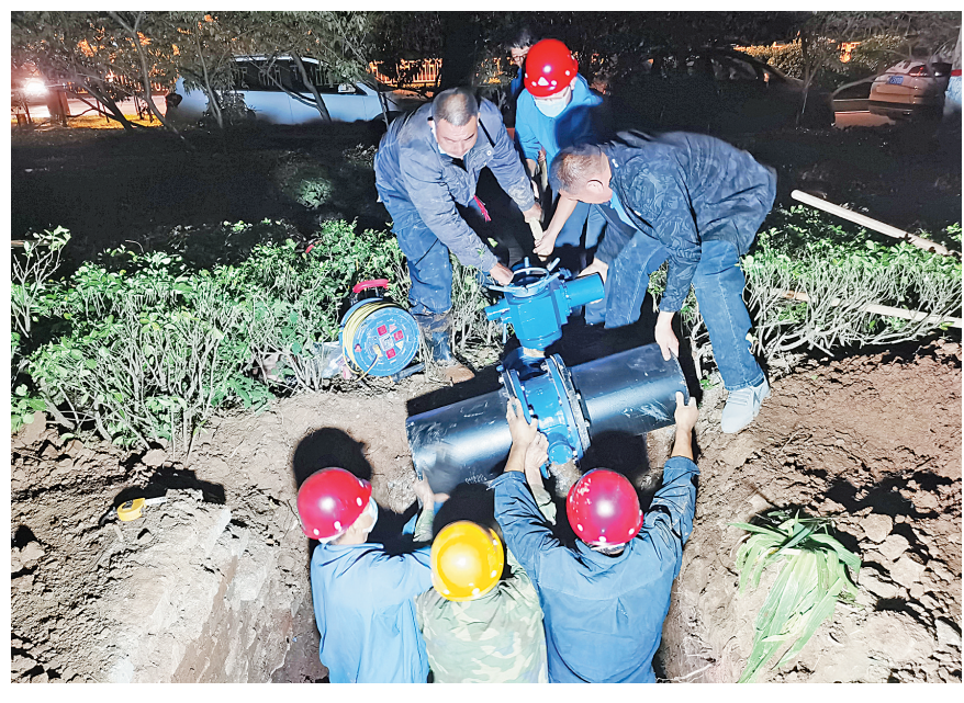
林州市自来水公司抢修人员在善德路北段加装供水主阀门(李晋杰 摄)
