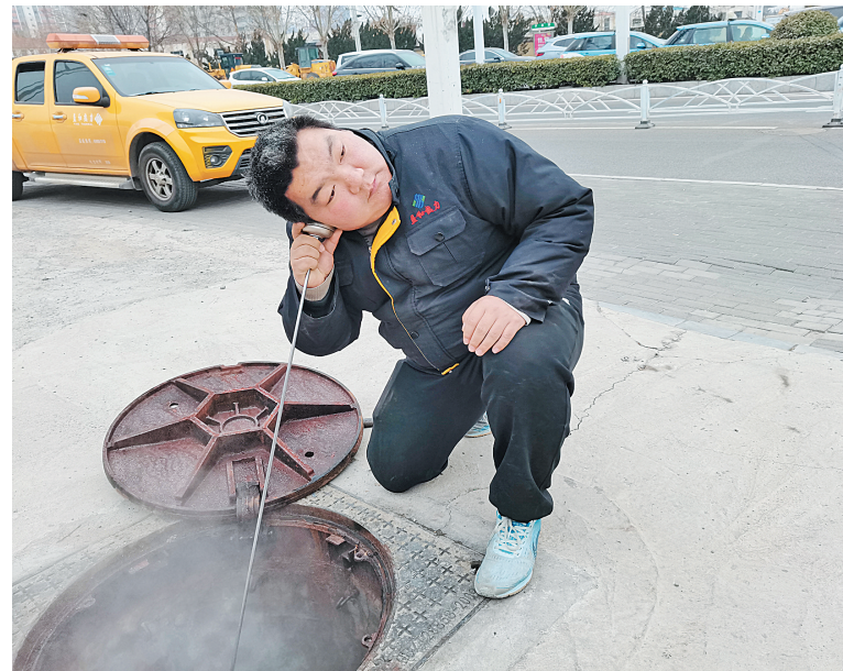
贺鑫兴正在热力井旁检测漏点(张承摄)
