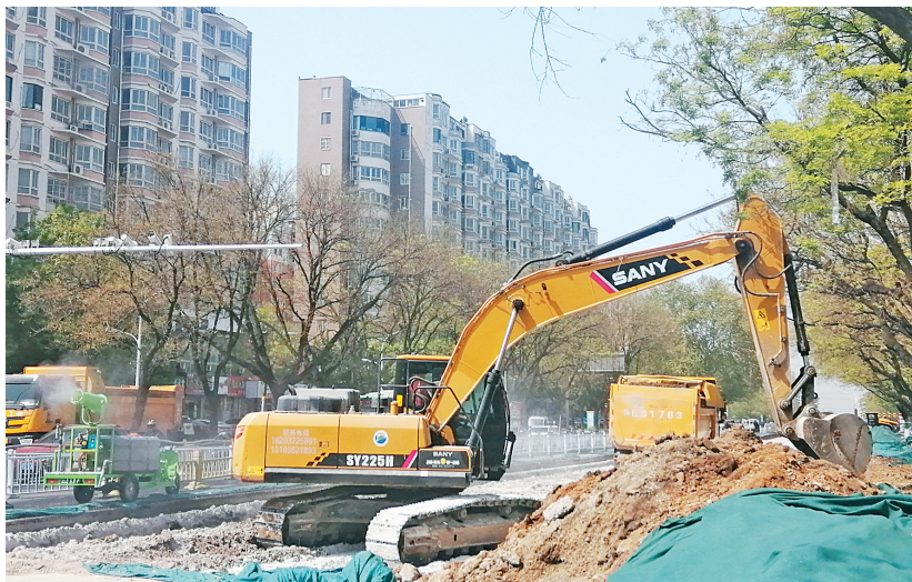
文明大道与彰德路交叉口附近雨水管网改造工程施工现场
