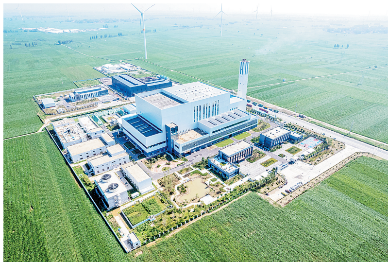
滑县静脉产业园运行中的垃圾焚烧发电项目(王子瑞 摄)
