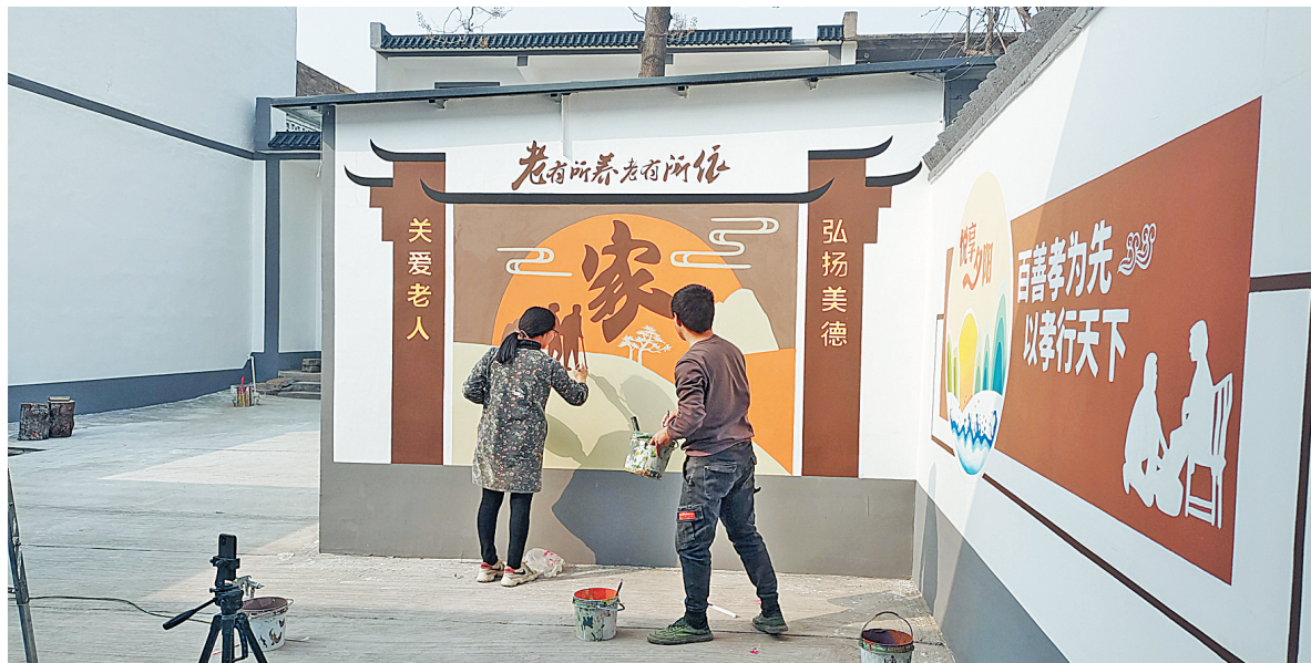
正在施工的日间照料中心(牛玉斌 摄)
