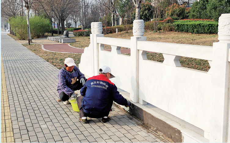
创文工作开展以来,安阳县住建局高度重视,成立工作专班、碎修队,对辖区主次干道进行地毯式排查,对发现的人行道塌陷、窞井盖缺失等进行及时修复和更新,施划主次干道标线,更换在建工地破损围挡,并张贴公益广告。图为3月21日,安阳县住建局施工人员进行修复破损桥栏。
