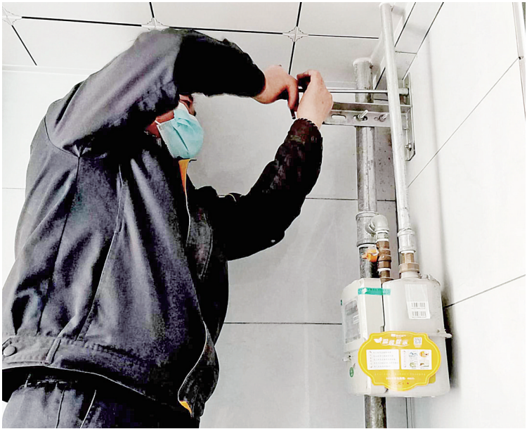
维修人员在用户家检修燃气设备(梅艳青 摄)
