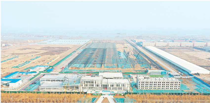
内黄县新型建材创新创业产业园项目建设现场(彭志帅 摄)
