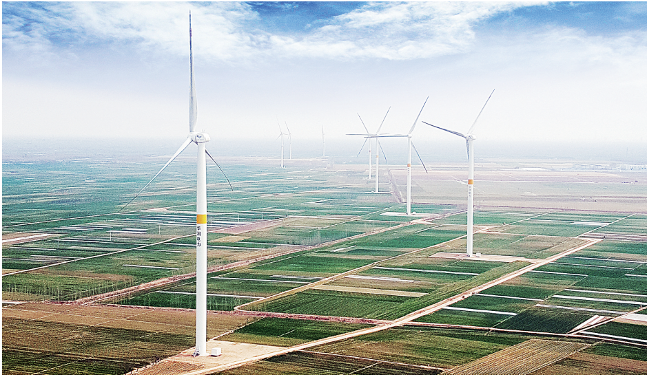
目前,我市风光新能源并网装机总容量已突破“双两百万”兆瓦,占安阳地区发电总装机容量的62.8%,规模、占比均位列全省第一。(张正全 摄)
