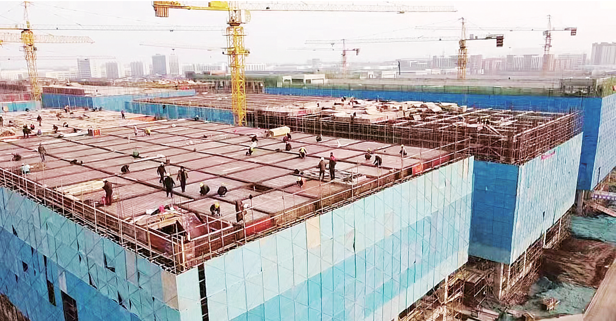
高端针织面料产业园项目建设现场(郑建业 摄)
