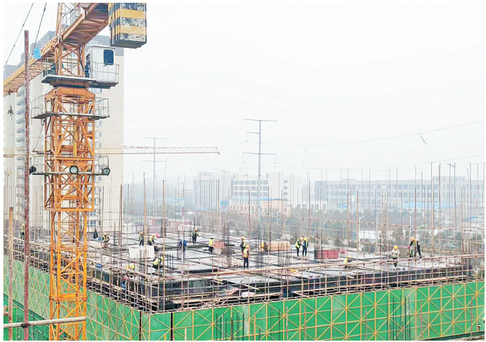
5G泛在低空技术应用示范基地项目建设现场
