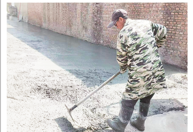
施工人员在硬化高庄镇背街小巷(乔光 摄)
