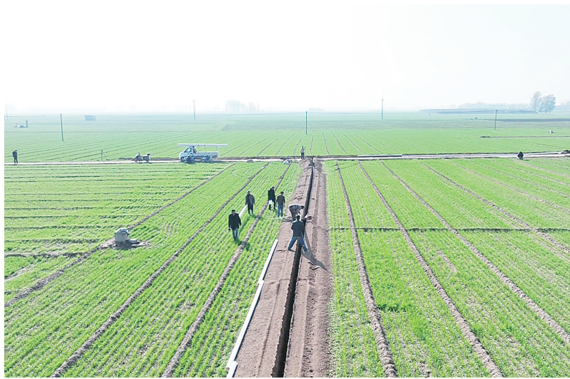
高标准农田建设项目施工现场(赵志刚 摄)
