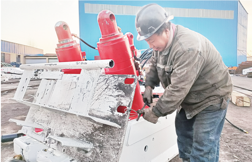
工人正在捆绑电缆(本报记者 姚芳 摄)
