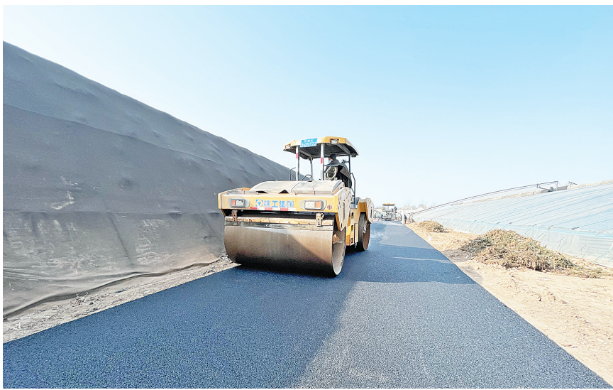
繁阳街道持续推进“四好农村路”建设,于1月7日开始对内郭路真武庙段进村路和村内街道铺设柏油路面。该路段的建设将提升大棚蔬菜、露地菜运输能力,实现路通业兴、路景联动,助力农村产业兴旺、生态宜居。图为施工现场。(郝林 摄)
