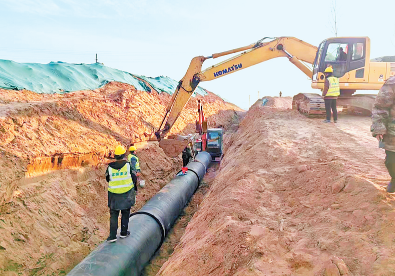
安阳县(示范区)城乡供水一体化工程施工现场(魏运平 摄)
