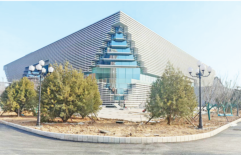
建设中的汤阴文化宫项目(原金贵 摄)
