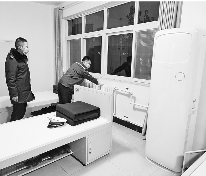
华润燃气内黄公司工作人员正在现场勘察评估内黄县消防救援大队供暖设施情况(赵冰 摄)
