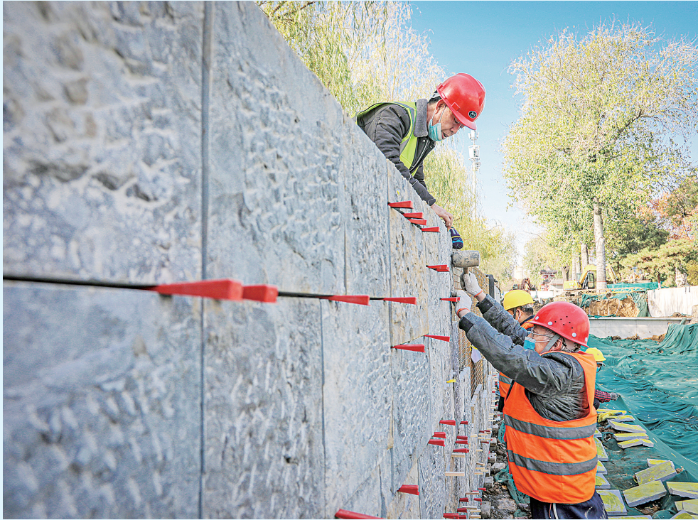
工人在为河道护坡铺设石材
