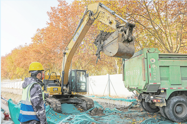
河道清淤及渣土外运
