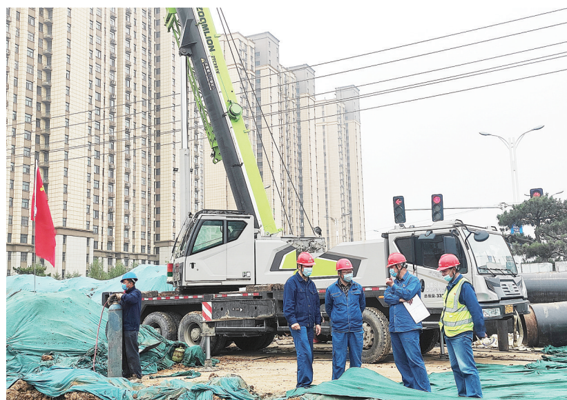
施工人员进行管网铺设 (本报记者 郭凡 摄)
