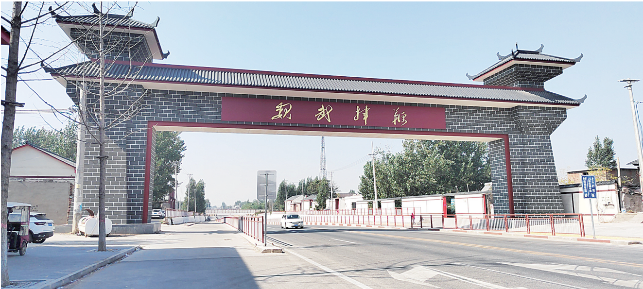
107国道安丰乡太平店村段整治后的新貌(本报记者 梁亚杰 摄)
