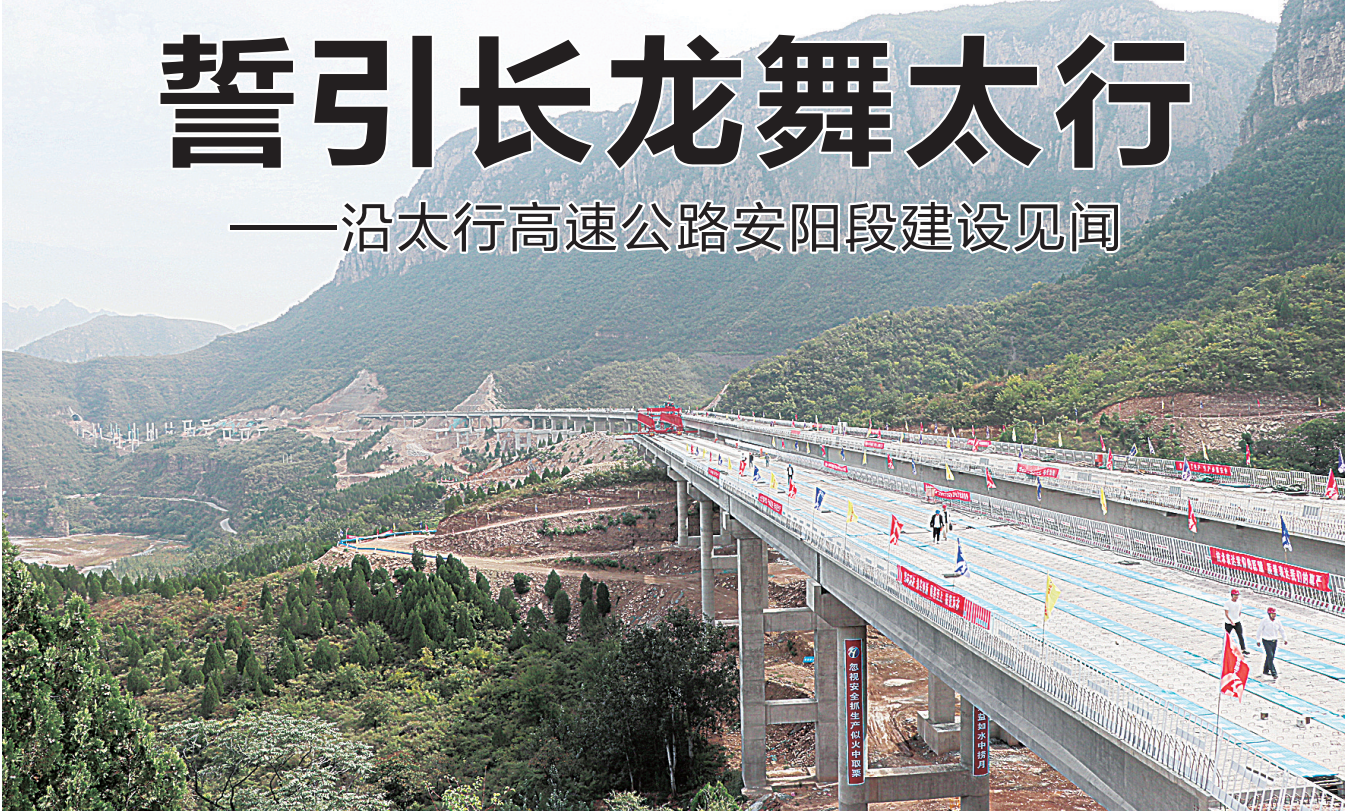
正在建设中的万宝山大桥
