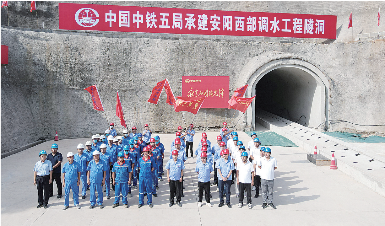
南水北调安阳市西部调水工程咽喉工程输水隧洞全线贯通
