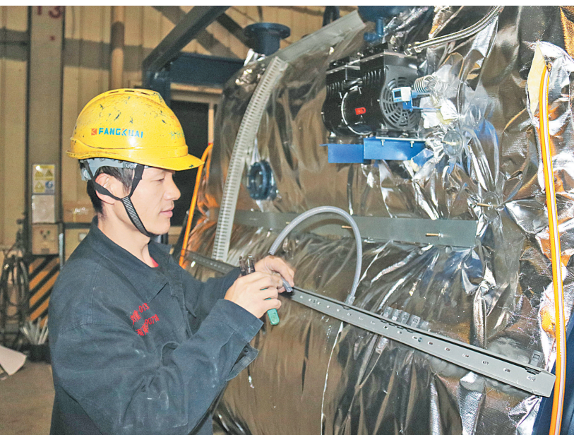
工人正在安装锅炉炉体控制线
