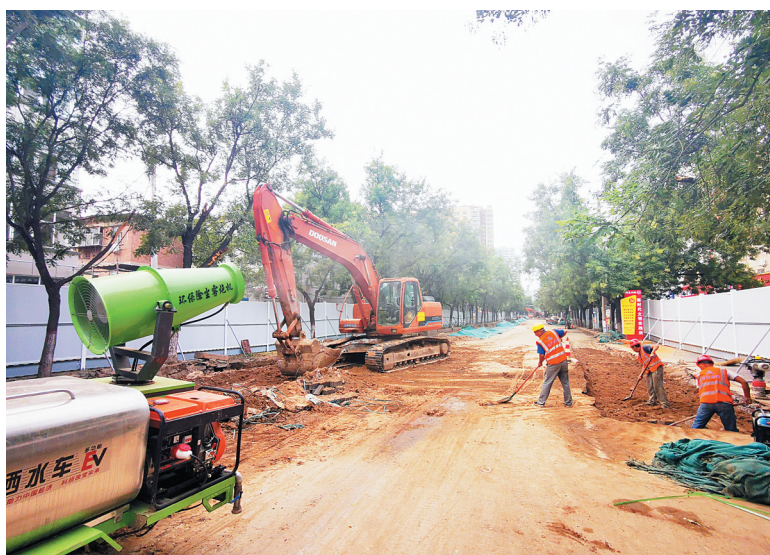
封闭施工现场
