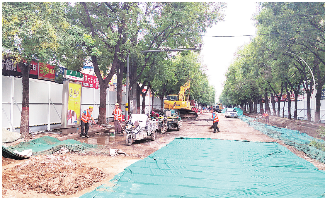
自8月18日起,东工路(盘庚街-明福街)雨水管网改造工程正式开工。该工程全长约4500米,北起盘庚街,南至明福街,机动车道宽16米。为保证东工路(盘庚街-明福街)雨水管网改造工程施工顺利进行,我市计划在8月18日至11月30日对东工路机动车道进行封闭。全长约402米的解放大道(火车站广场-彰德路)雨水管网改造工程也将于同一时段对机动车道进行封闭施工。施工期间,为避免道路堵塞,还请各位市民尽量绕行。如须通过此路段的市民,请尽量选择公共交通、非机动车出行。图为8月30日下午,正在施工的东工路(盘庚街-明福街)雨水管网改造施工现场。(本报记者 牛思明 摄)
