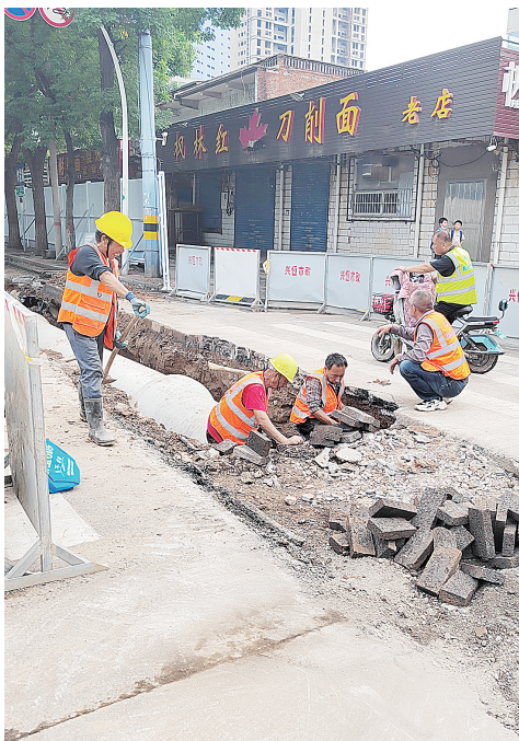
道路雨水管网改造进行中
