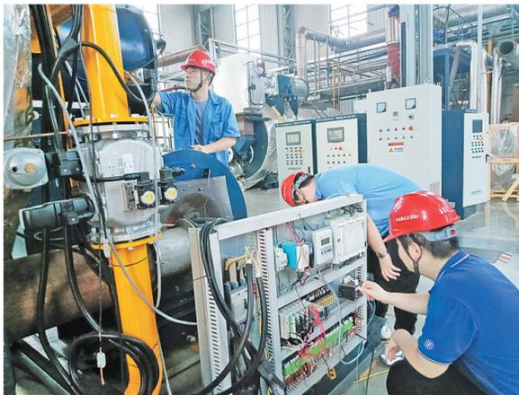
研发中心员工正在进行锅炉燃烧器调试
