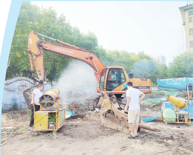
施工队施工改造现场
