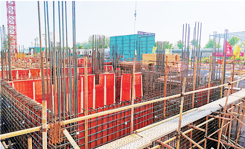
旭阳盖板玻璃项目二期厂房基础建设(李新 摄)
