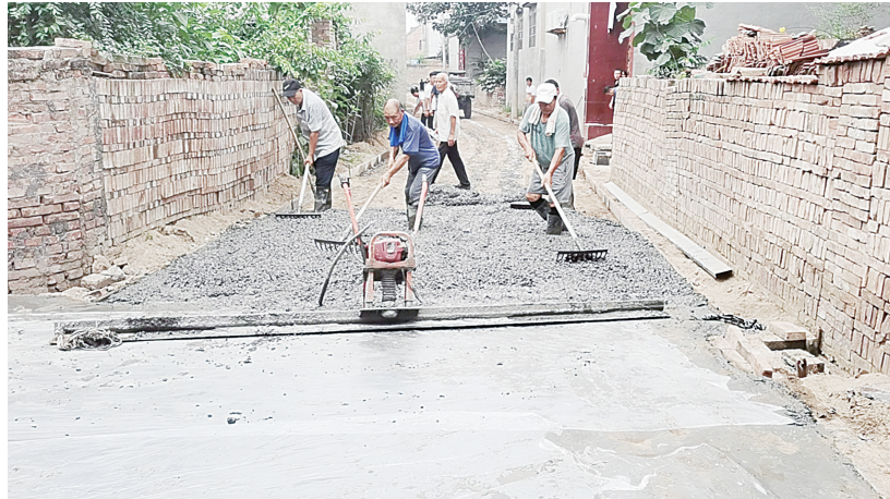
东悦庄村道路施工现场(王诗雅 摄)
