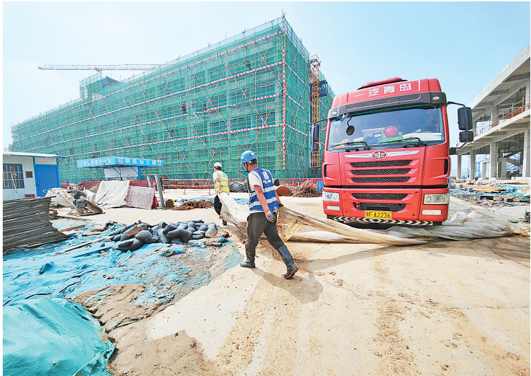
项目施工现场
